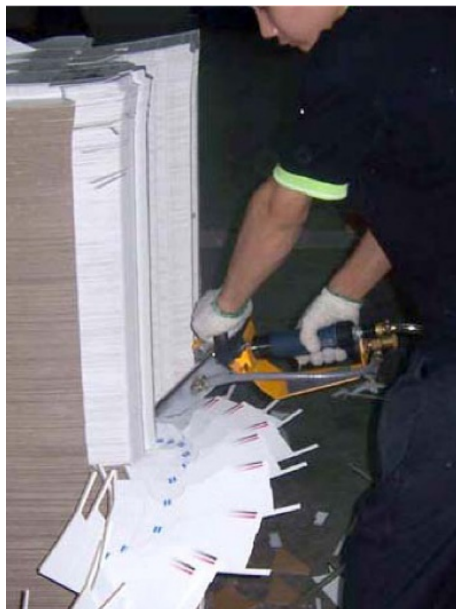
Figur 4 Eksempel på en utbrytningsprosess på en skorstein
